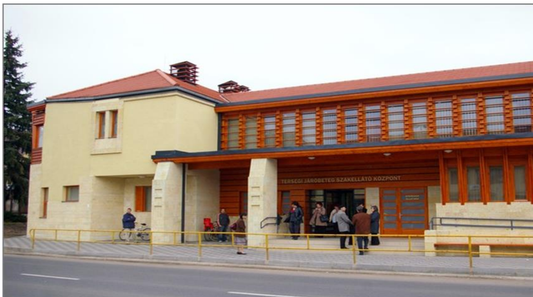
PÉTEGISZ Járóbeteg szakellátó épülete
