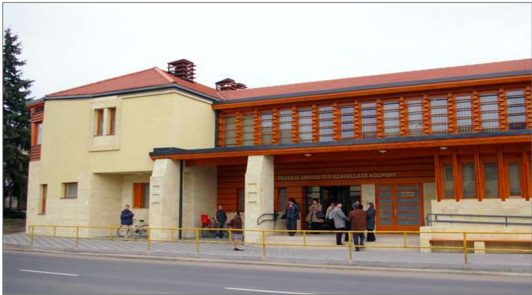
PÉTEGISZ Járóbeteg szakellátó épülete
