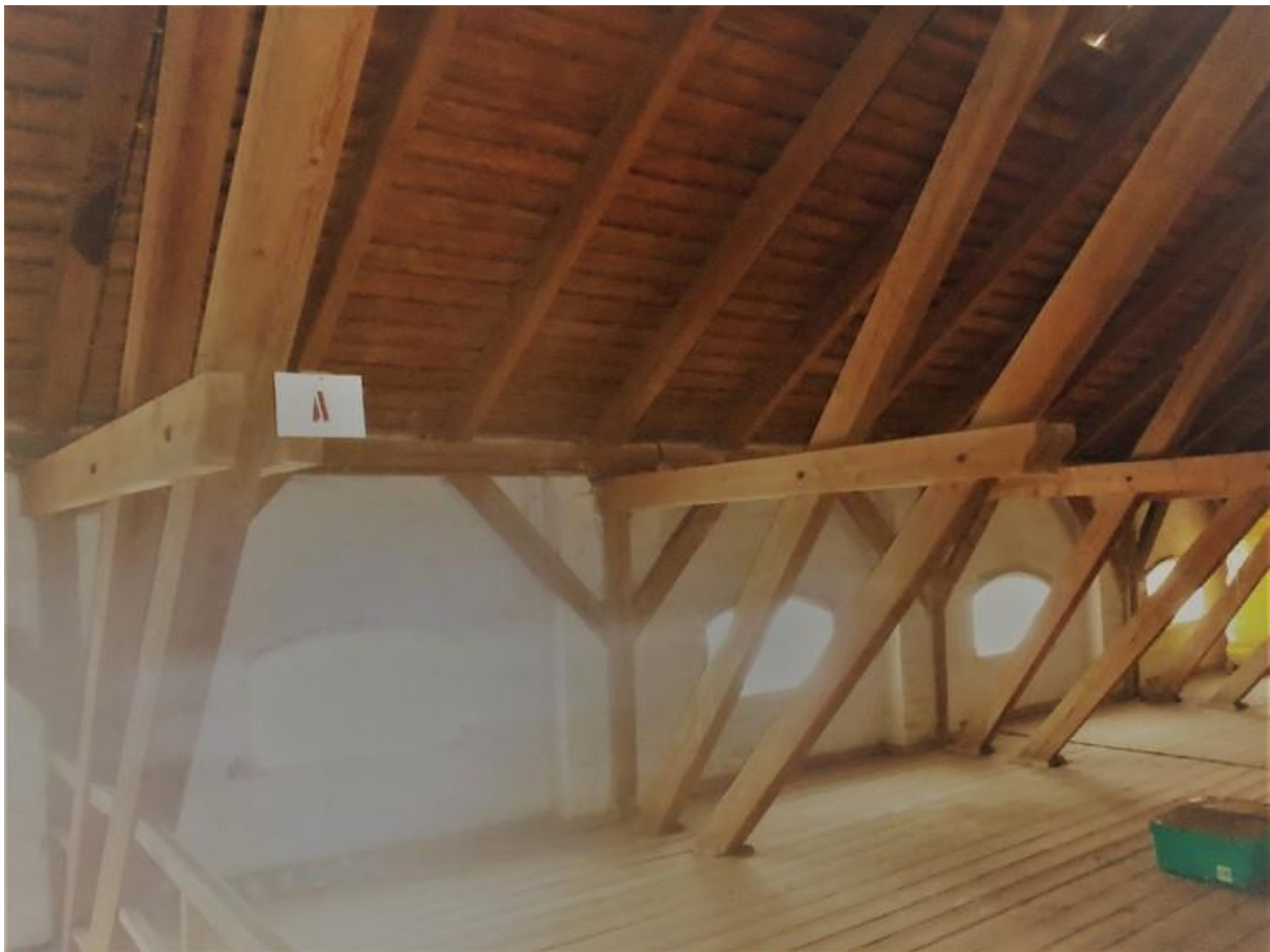
A tetőtér kialakítása
